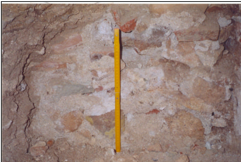
Foto 2.- Vista frontal de detall del mur U.E. 105
