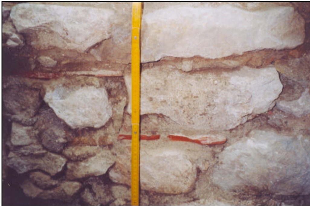
Foto 3.- Vista frontal de detall del mur U.E. 102
