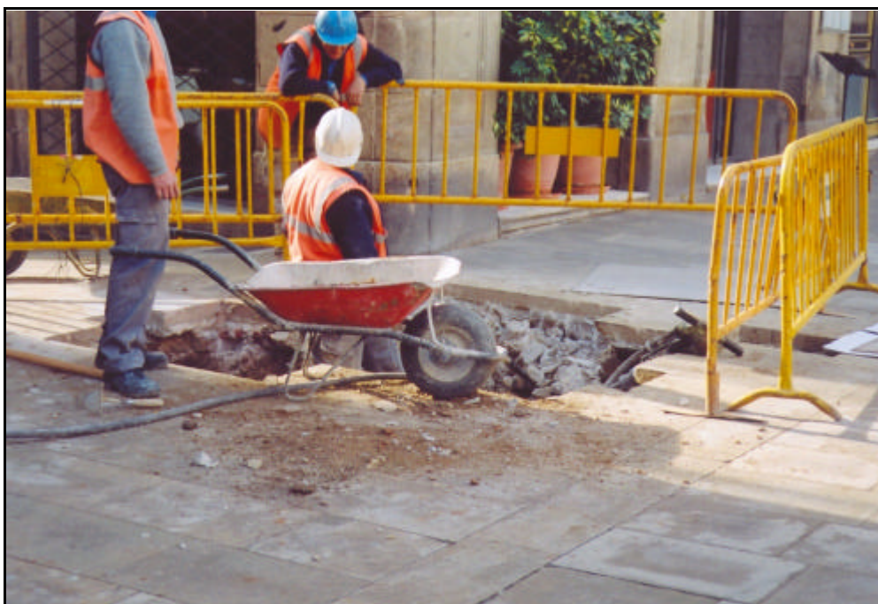
Foto 5.- Vista general de la situació de la RASA 4
